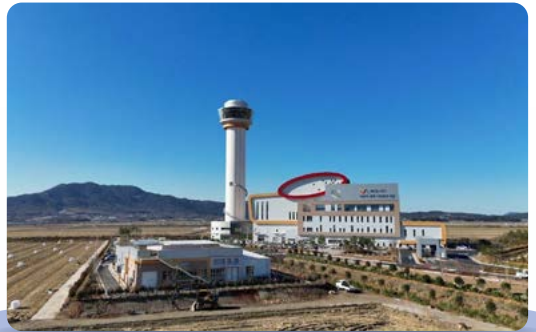
친환경 관광체험시설 자원회수시설 준공
