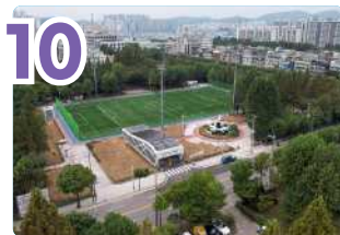
신트리공원 지하주차장 준공
