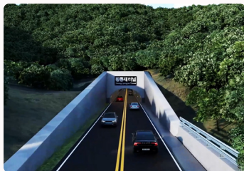
오랜 숙원 사업 황룡재 터널 건설 2026년 보상 예정
