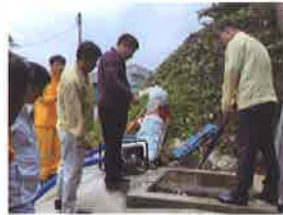
미진 이지비아 2차 인근 통로 박스 침수 방지 펌프 용량 확대 7억원
