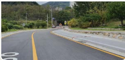
[ 내서 수곡 공장진입 도시계획 도로 개설 ]
