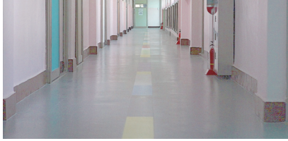
연희초 바닥 공사
