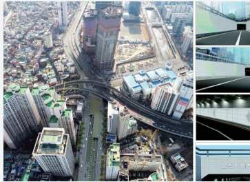
문전교차로 지하철도 건설
