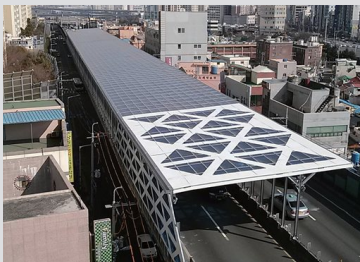
신개금 LG 동서고가도로 방음벽 설치
