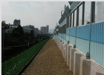
개금철로변 방음벽 설치
