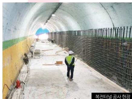
북전터널 공사 현장
