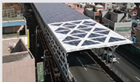
동서고가도로 방음벽 설치
