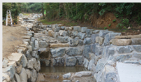
개금2동 국민주택 일원 재해예방공사
