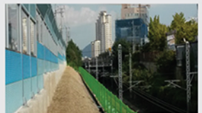
개금철로변 방음벽 설치
