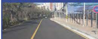
29. 중앙여고 ~ 동래중 도로 확장 공사
