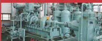
28. 명륜배수펌프장 노후펌프 교체 및 특고압수전판 캐노피 설치
