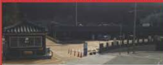
25. 동래문화회관 공영주차장 확장공사
