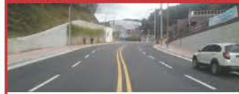
23. 동래문화회관 일원 도로확장 공사
