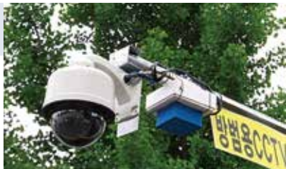
[노후 CCTV 개보수]
