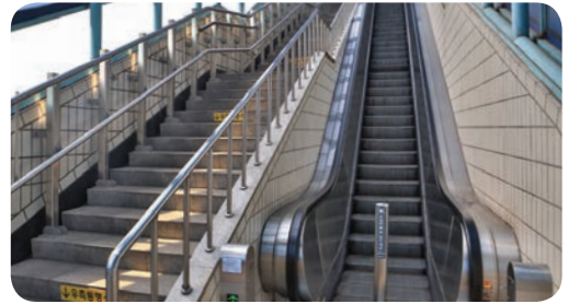
▲ 구로역 에스컬레이터 설치
