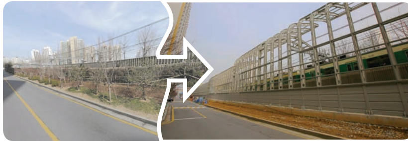
▲ 구로5동 철길변 방음벽 설치
