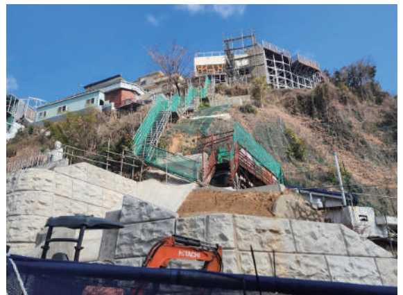
호천마을 경사형 엘리베이터 설치 현장
