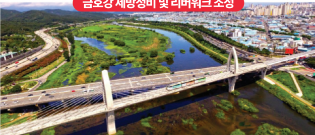
하중도 북편 금호강 제방 및 환경정비, 산책로와 자전거길 조성
