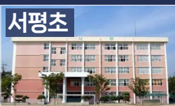
교사동 화장실 보수
