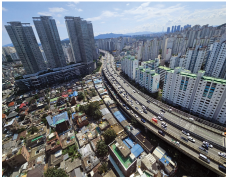
하월곡동 내부순환로 전경
